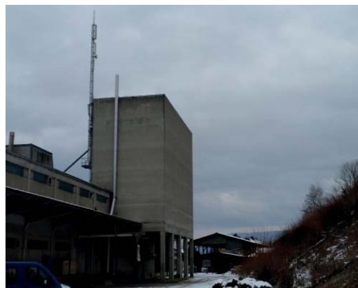
Abb. 2 Bestehende Siloanlage mit Natelantenne und Kamin
